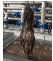
Lingettes agglomérées autour d'un équipement : une des principales causes de dysfonctionnement en station d'épuration
